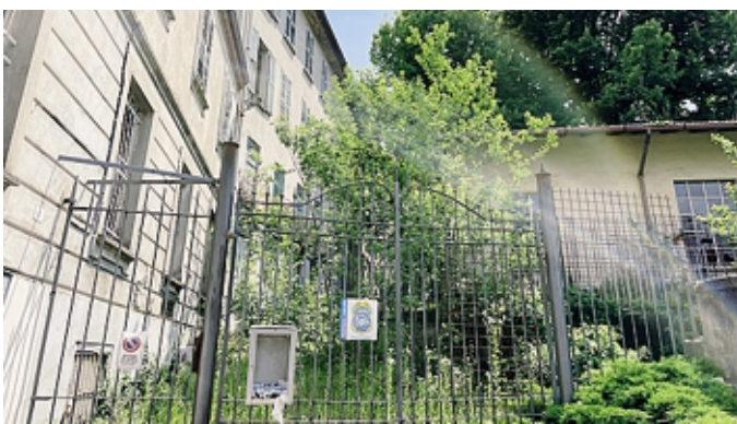
Le condizioni attuali dell'area, all'ingresso di Salita Camuzio
